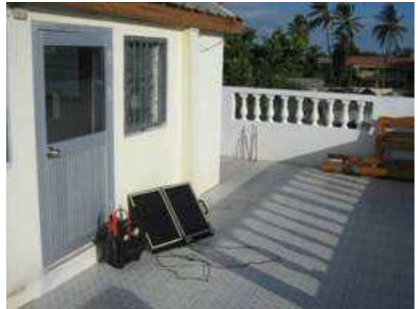
Foto Nr. 26 Aufladen einer Batterie mittels Solarpanel
