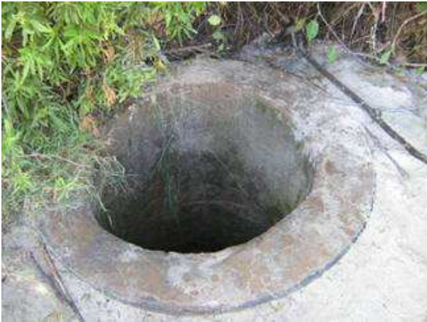
Foto Nr. 19 Brunnen mit Wänden aus Beton
