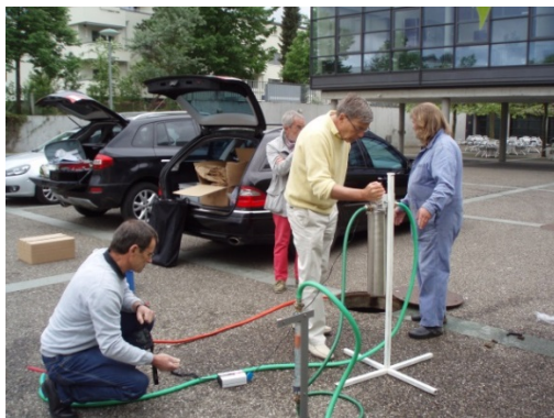
Kurt Wälti und Max Egli zusammen mit dem Abwart des kvBL beim Installieren des Waterflow 400 Systems oberhalb des Regenwassertankes.
