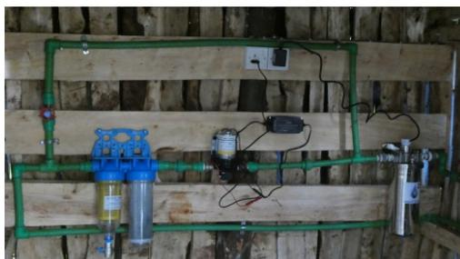
Die zuverlässigen Installateure vor Ort haben das Waterflow 250 montiert. Zum ersten Mal kam hier auch ein Vorfilter mit Rückspülfunktion zum Einsatz.
